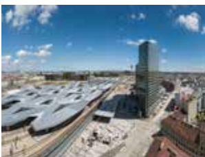
Projekt: Hauptbahnhof Wien
