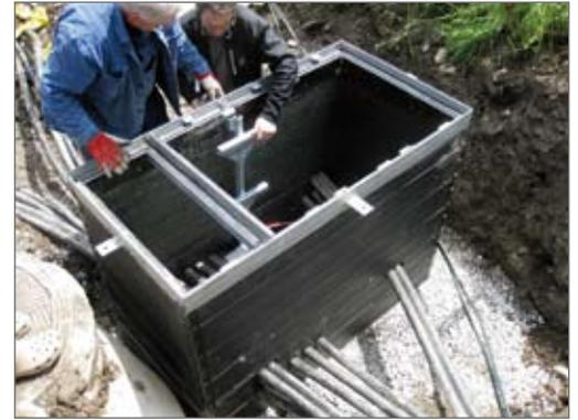
ben. Aufsetzen der Erhöhungselemente (100 mm oder 200 mm Profile) und Montage des Kopfrahmens (Einsetzen der Clips zur Fixierung). Anschließend Ausziehen der teleskopierbaren Vertikalleisten um die Höhe der Schachterhöhung und Fixierung der Teleskopvertikalleisten durch Verschrauben. Hinweis: evtl. Horizontalprofile sind auf mittlere Schachthöhe zu montieren. Bei einer Erhöhung der Bauhöhe über 1,20 m bzw. 1,60 m ist ein zusätzliches Horizontalprofil zu verwenden.
