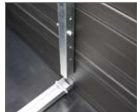
Die bauseitige Herstellung der Einführungsöffnungen erfolgt durch Anzeichnen der Einführungsöffnungen knapp unterhalb der Elementfuge (Fuge zwischen den einzelnen Profilen) und Bohren mittels handelsüblicher Bohrmaschine oder Akku-Bohrmaschine mit Kronenbohrer.
