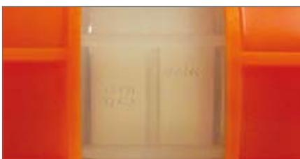
Rechtes Rohr bis zum Anschlag eingeschoben.
