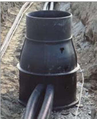
Steigstufen sind bei Bedarf (Kabeleinbau) zu entfernen.
