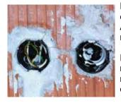
Hier stellt der Innenputz die Luftdichteebene zu Außenwänden bzw. Wohnungstrennwänden dar.
