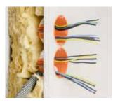
Hier wird eine diffusionshemmende Dampfbremse auf der warmen Seite der Dä mmung eingezogen, die keine Undichtigkeiten aufweisen darf.
